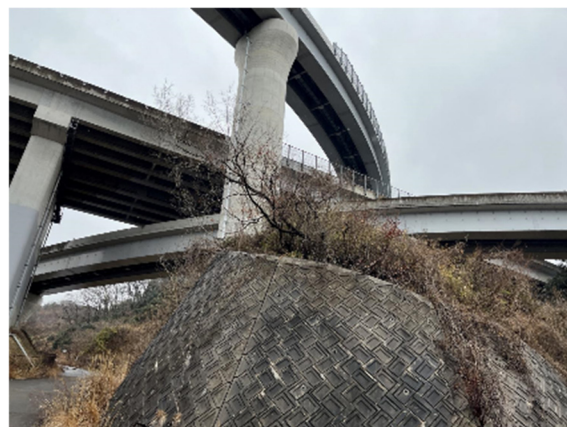
写真-2 図-7の現地写真 (2025年3月4日撮影)
