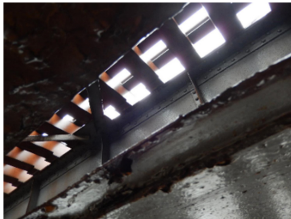
写真-3 図-8の現地写真 (2025年3月4日撮影)
