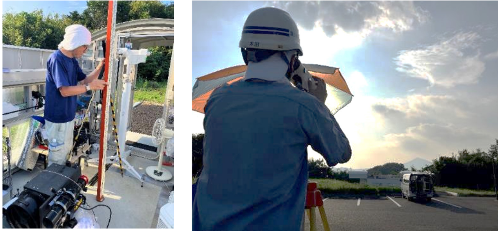
写真-4 設置された金属標と、器高式水準測量を実施している様子
