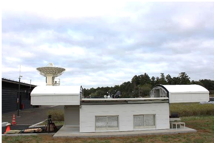
写真-2 石岡局に設置されたスライドルーフ式 SLR 観測室（屋根が開いた状態）
