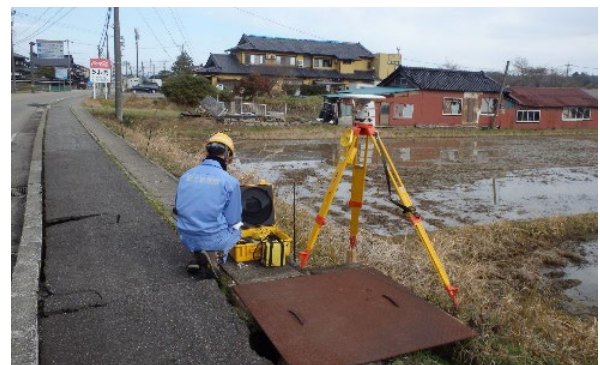
写真-9 公共基準点「基II-5」でのGNSS観測(1月31日)。
