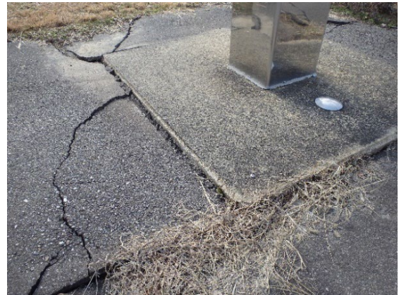
写真-7 電子基準点「能登島」の基礎部分(1月31日)。
