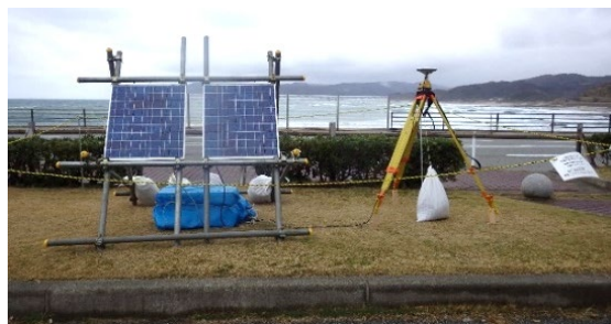
写真-6 小型GNSS観測装置「赤神」。1月21日設置。
