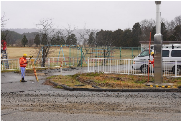
写真-3 電子基準点「富来」における緊急調査の様子。
