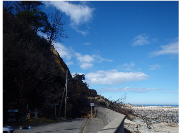
写真-4 電子基準点「P輪島」の所在場所における斜面崩壊の状況。
