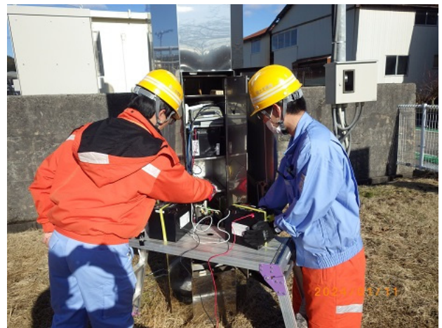
写真-2 電子基準点「穴水」におけるバッテリー交換作業。
