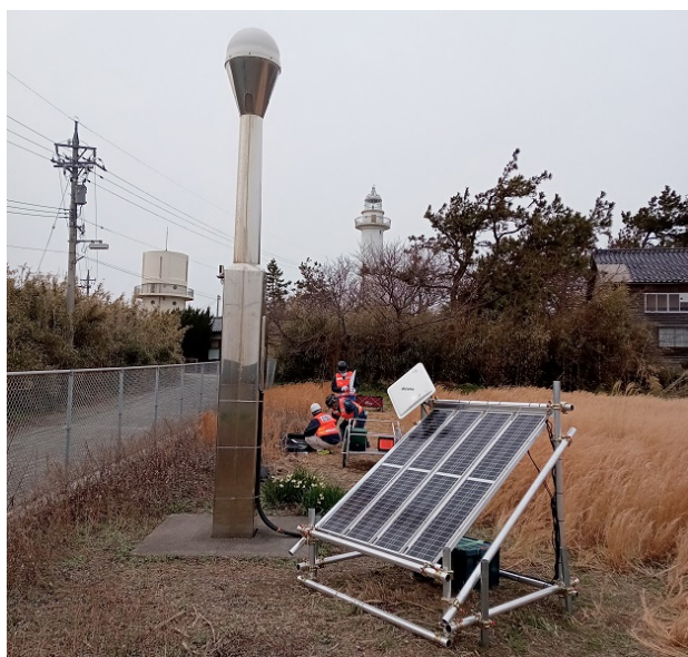
写真-5 電子基準点「舢倉島」緊急復旧作業の風景。
