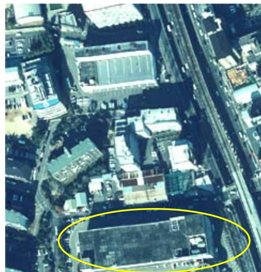
建物の局所歪み
