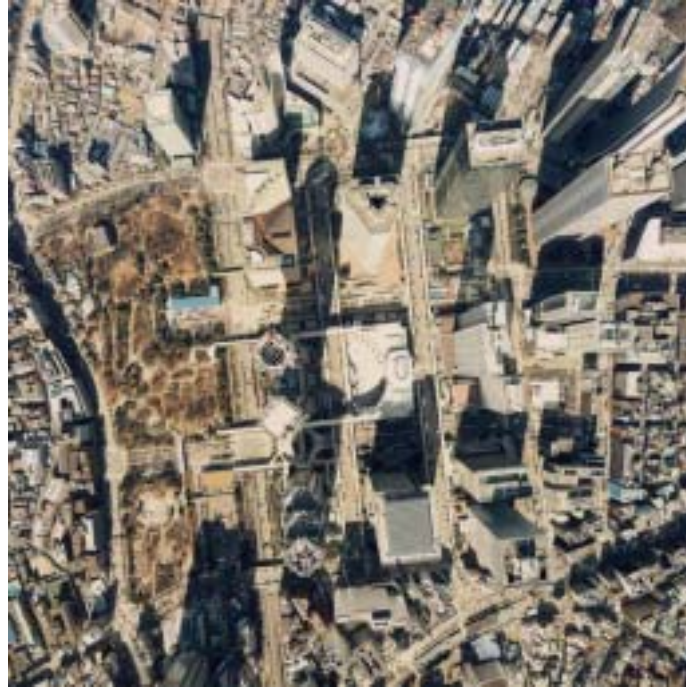
比高差による建物の倒れ
