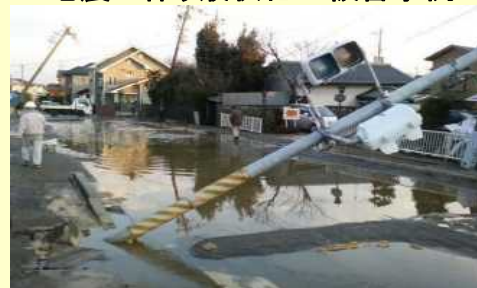
平成23年(2011年)東北地方太平洋沖地震に伴う液状化の被害事例
