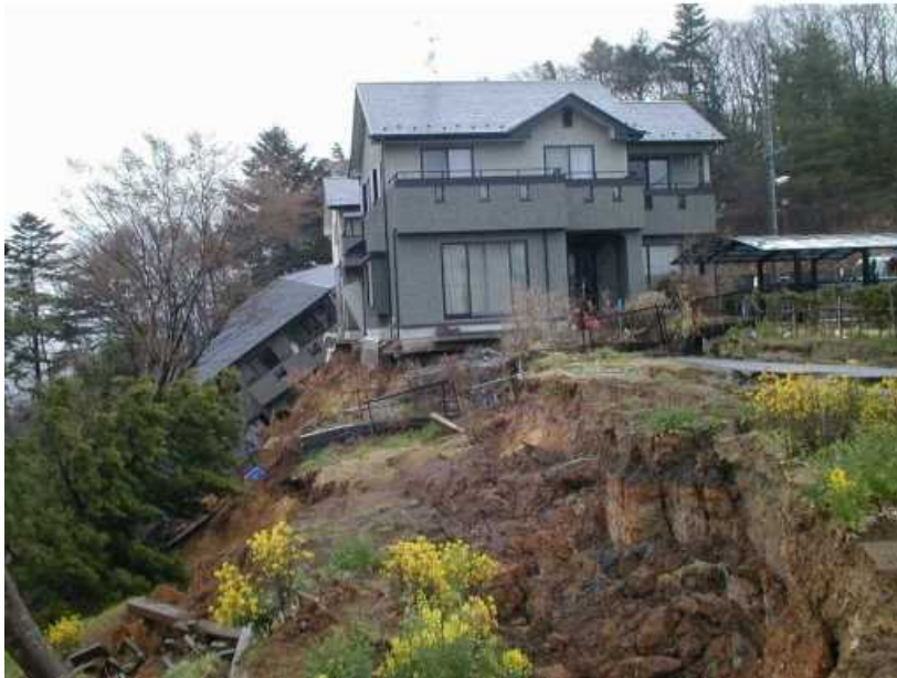
平成23年東北地方太平洋沖地震により発生した 滑動崩落 (国土交通省資料)
