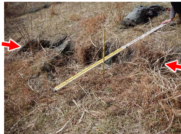
写真-1 地点1で確認した地表変位(赤矢印の区間)
