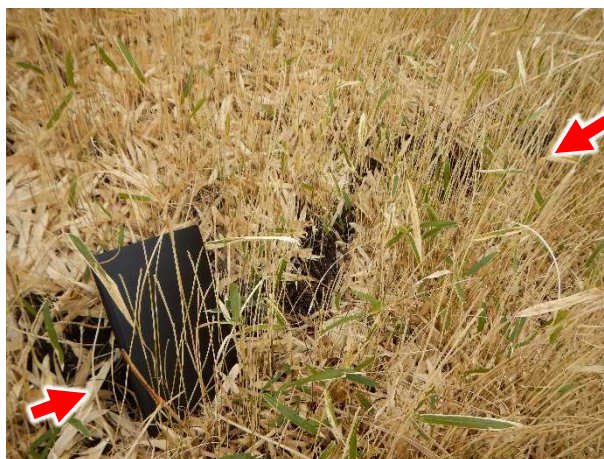
写真-4 地点4で確認した地表変位(赤矢印の区間)
