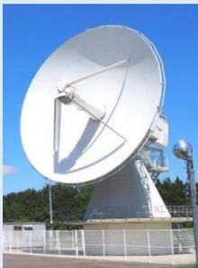
石岡VLBIアンテナは、石岡測地観測局（茨城県石岡市）に設置されている直径13.2mのパラボラアンテナです。このアンテナは、毎秒12度（30秒で1回転）ととても速く動くことができます。国土地理院では、このアンテナを用いて日本の基準を決めるとともに、プレート運動や地球の自転の様子などを観測しています。
