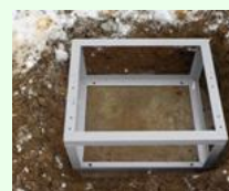
架台設置状況 (基礎に固定)
