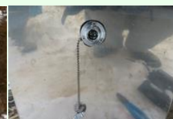
防水コネクタ 設置状況
