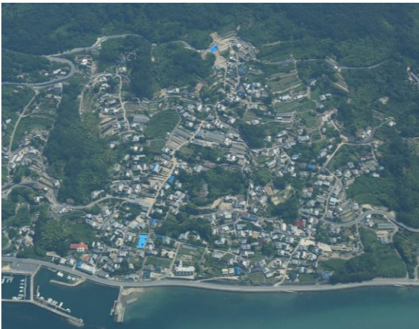
写真-1 江田島地区の状況写真（一部拡大）
