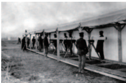
写真 1 基線尺による基線測量 相模野基線（神奈川県）
