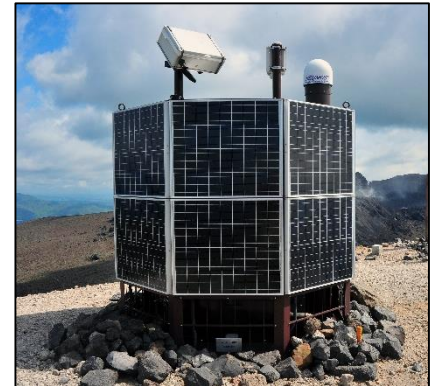
GNSS火山変動リモート観測
