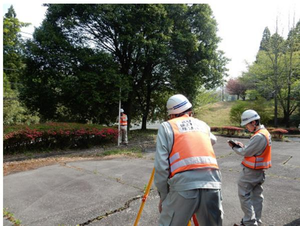
写真-1 電子基準点「長陽」における傾斜測定
