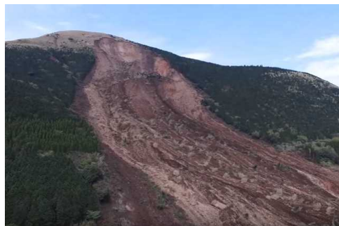
図-2 UAV で撮影した阿蘇大橋周辺の土砂崩壊箇所
