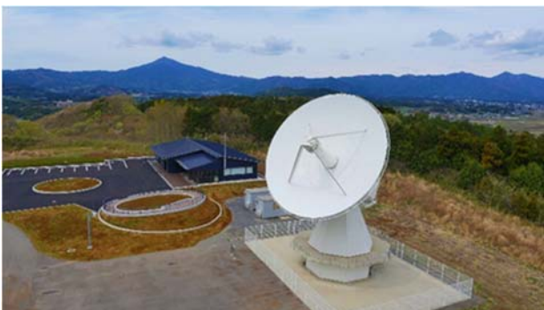
写真-1 石岡測地観測局。パラボラアンテナ左奥の平屋建てが観測局舎。奥は筑波山。
