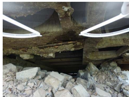
天守閣の石垣と建物の間
