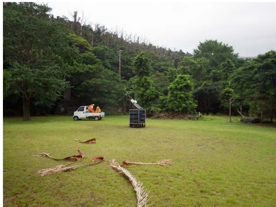
写真-6 設置された REGMOS
