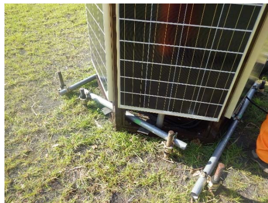
写真-7 ベースフレームの固定補強
