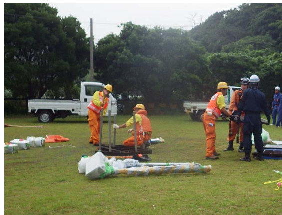
写真-4 組立て作業中
