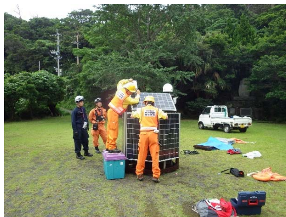
写真-5 設置完了
