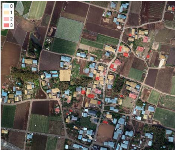
図-3 大砂の被害状況の区分
