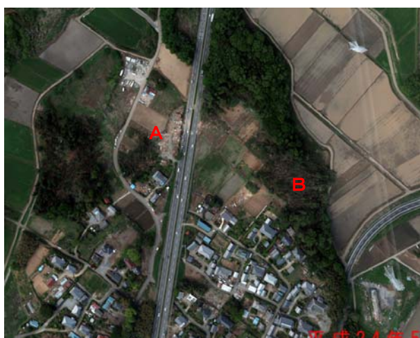
図-5 山木の国道408号線周辺の災害後の空中写真
