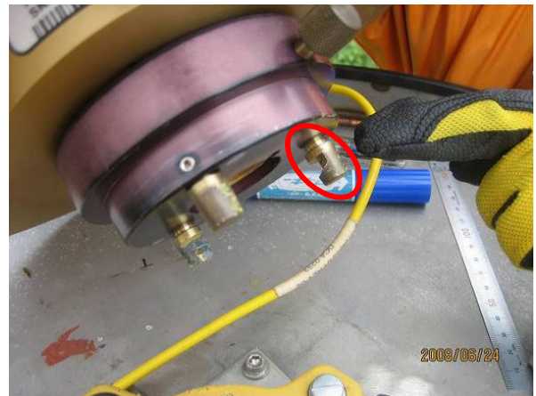
写真 - 4 回転台座留め金の緩み
