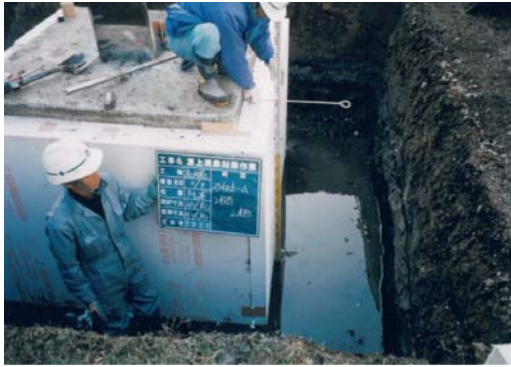
図-4 「阿寒2」の凍上対策工事写真
