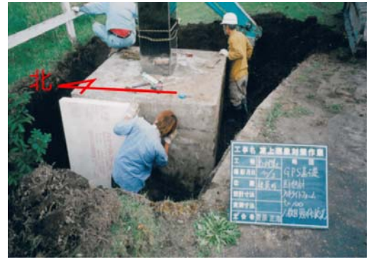
図-5 「標茶」の凍上対策工事写真
