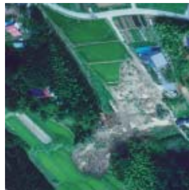
写真-17 崩壊地斜め写真（朝日航空撮影を方向改変）
