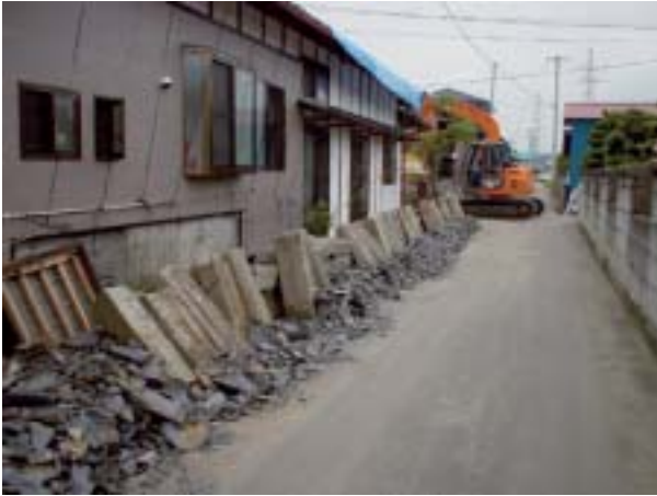
写真-16 砂押地区における家屋被害
