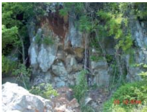
写真-11 多数の亀裂を生じた崖の表面
