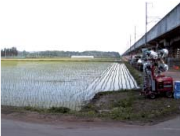
写真-6 損傷箇所付近の河岸段丘面
