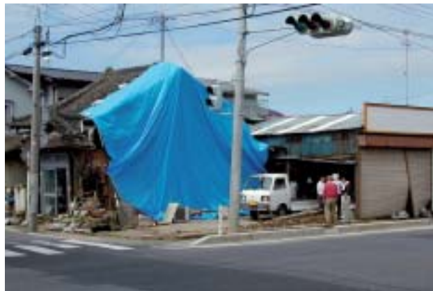
写真一3 電子基準点「矢本」付近の倒壊家屋
