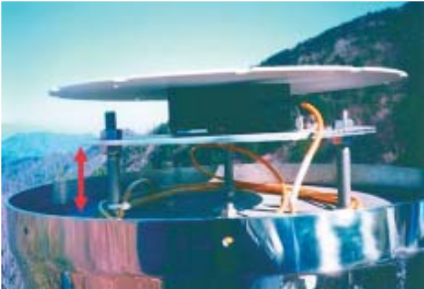
写真-1 95年型架台のアンテナ設置状況。赤い矢印がアンテナ架台取り付け高を示す。
