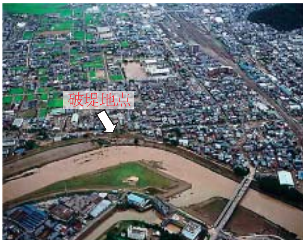
写真－3 足羽川の破堤箇所 (福井市春日, 国際航業(株)撮影)
