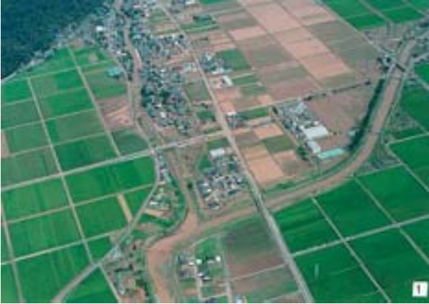
写真－6 河和田川の越水箇所 (鯖江市落井町, 国際航業㈱撮影)
