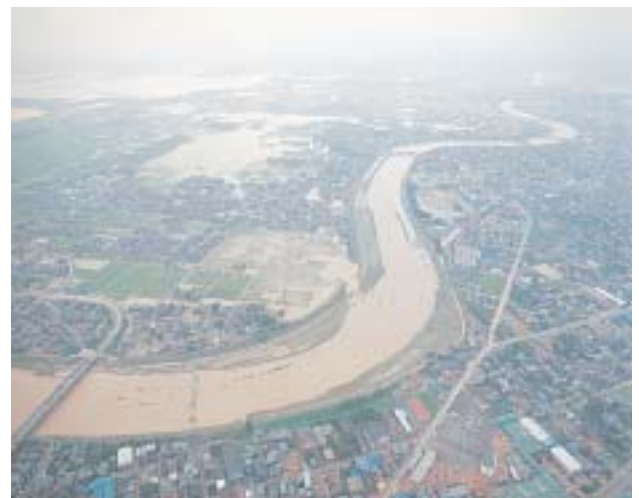
写真-1 五十嵐川左岸の破堤地点（朝日航洋㈱撮影）
