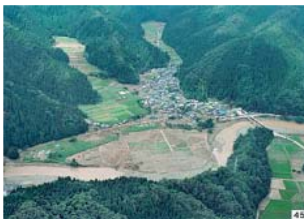
写真－5 足羽川の破堤箇所 (美山町蔵作, 国際航業(株)撮影)
