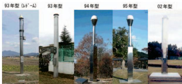
写真－3 アンテナ架台形状
