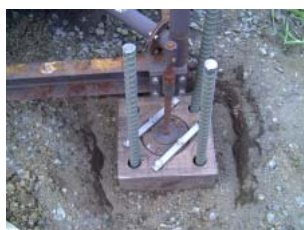
写真-5 木製基台装着 作業 (M-阿古)
