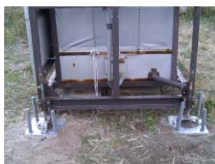
写真-6 ステンレス 製基台の装着 (M-阿土山)
