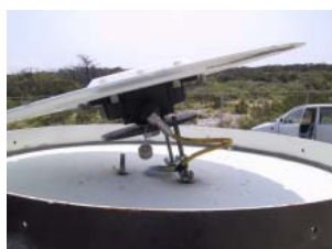
写真-7 M-新島灯台
