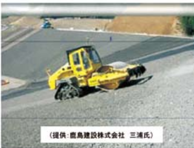
図-14 振動ローラーに取り付けたネットワーク型RTK装置
