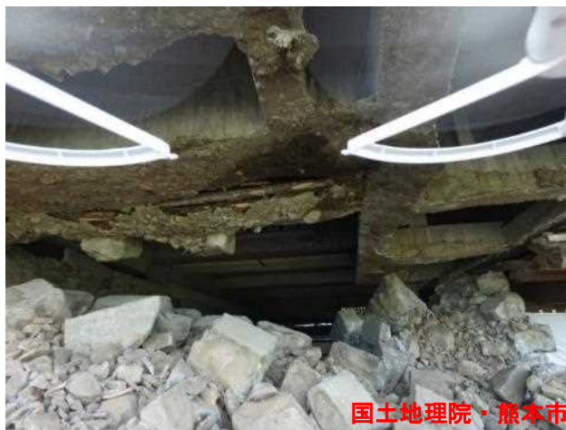
東側の石垣と建物の間
