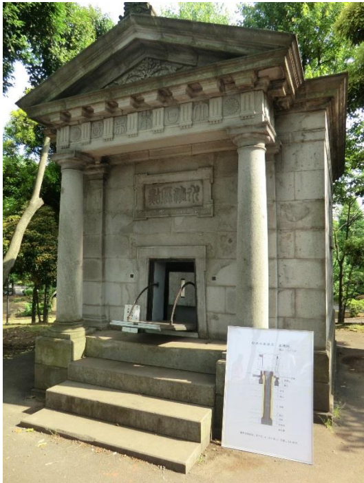
写真-1 日本水準原点 この 24.3900 m 下に東京湾平均海面がある。
