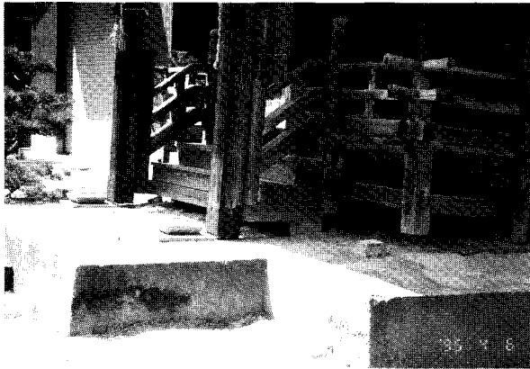
写真-7 土台と建物のずれ (笹神村高田 熊野神社)
